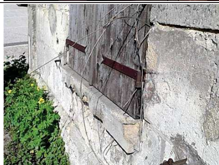
Photo n° PhA010 Localisation : Parties extérieures Ouvrage : Murs extérieurs Partie d'ouvrage : Joint ciment Description : Mur extérieur jointoiement ciment Localisation sur croquis : M010
