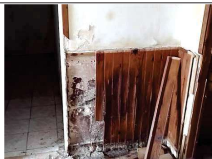
Photo n° PhA009 Localisation : Parties intérieures Ouvrage : Mur pierre extérieur Partie d'ouvrage : Joint ciment Description : Mur pierre jointoiement ciment Localisation sur croquis : M009
